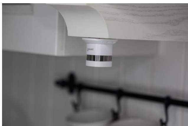
Рисунок 4 – Варианты установки датчика дыма
